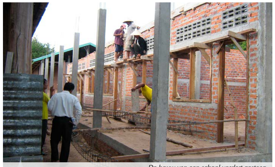
De bouw van een school vordert gestaag.
